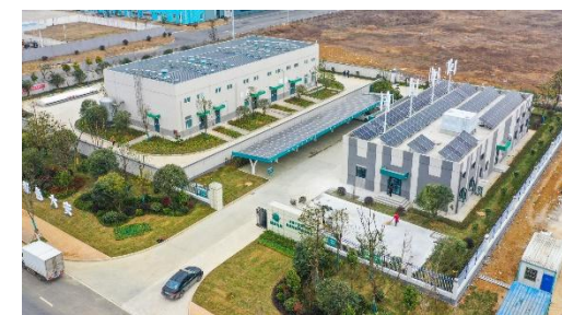
六安氢能综合利用站
